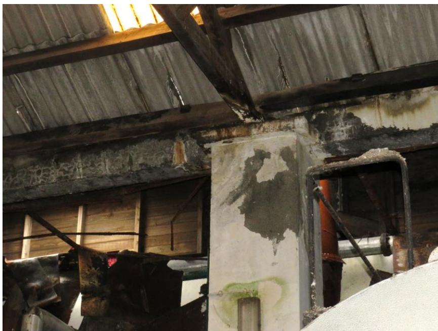
Figura 68 – Destacamento de pintura, corrosão de elementos metálicos e sinais de podridão dos elementos de madeira da estrutura da cobertura no compartimento 11.4.
