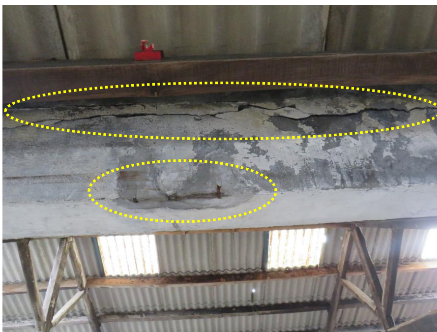
Figura 77 – Fissuração, destacamento de betão da camada de recobrimento e corrosão de armadura em viga na cobertura do Piso 1, sobre o compartimento 11.3.
