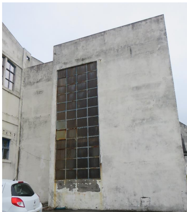
Figura 7 – Corrosão dos elementos metálicos de suporte do envidraçado na fachada Poente. Degradação e destacamento da pintura.
