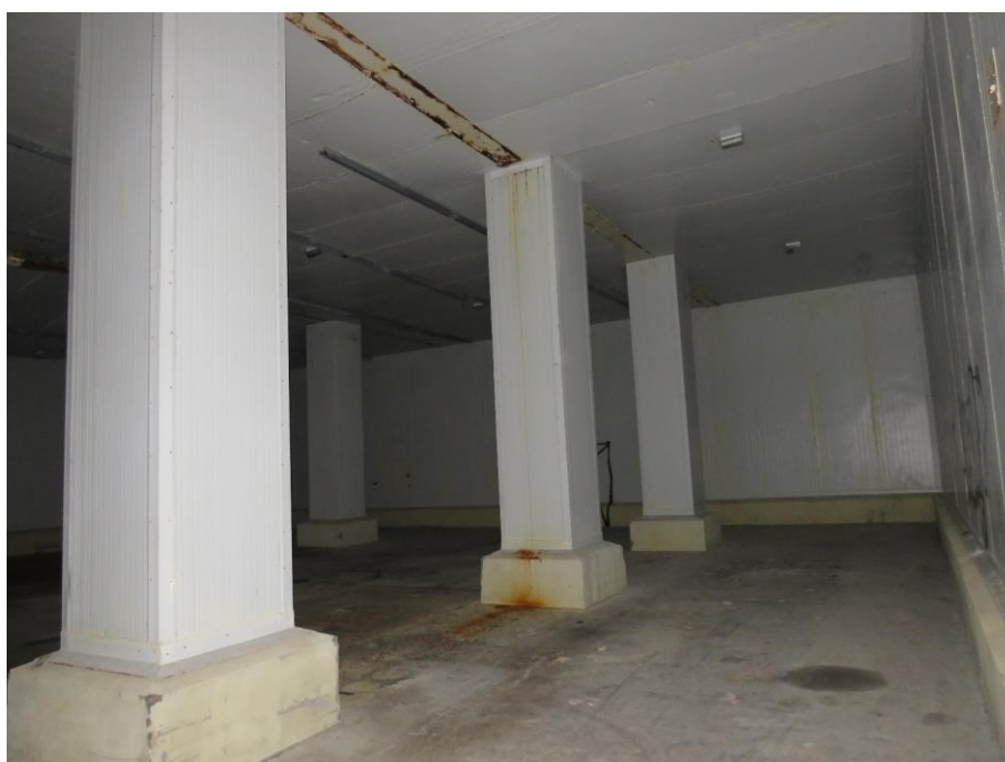
Figura 65 – Fissuração e corrosão de elementos metálicos nas zona de frio.
