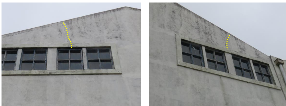
Figura 22 – Fissuras observadas no topo da fachada Sul.
