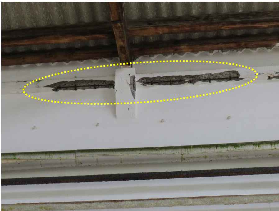
Figura 61 – Queda da camada de betão de recobrimento em vigas, corrosão de armadura e de tubagem. Sinais de podridão da madeira da estrutura da cobertura.
