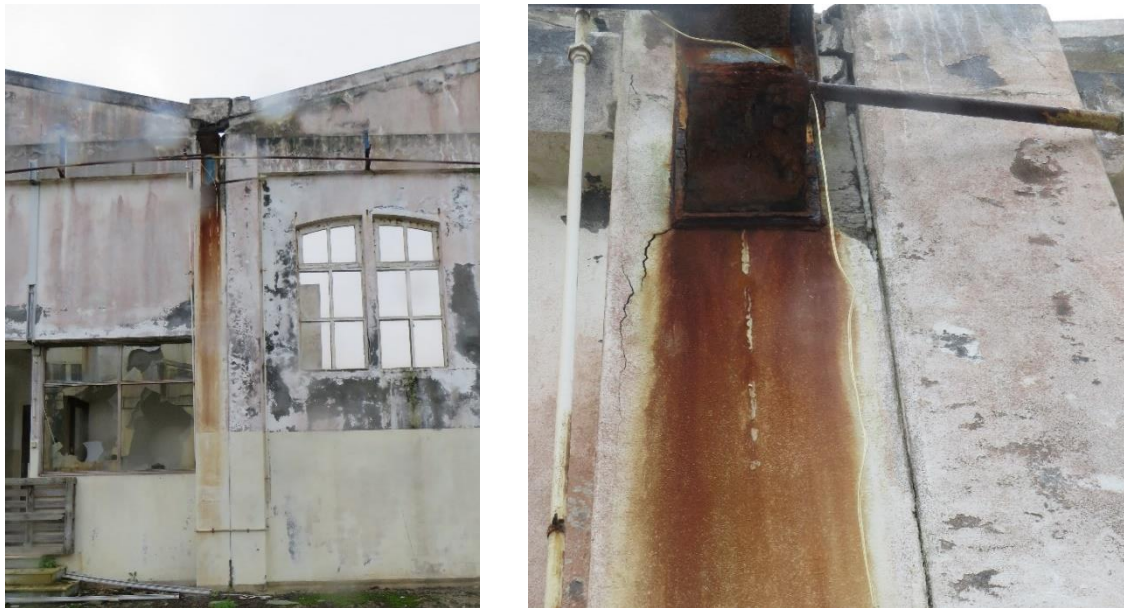
Figura 15 – Fissuras e corrosão de elementos metálicos na zona da junta de dilatação, na fachada Sul do edifício.
