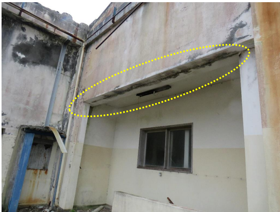
Figura 16 – Destacamento de betão da camada de recobrimento e corrosão de armaduras na face inferior de lintel, no Piso 1.
