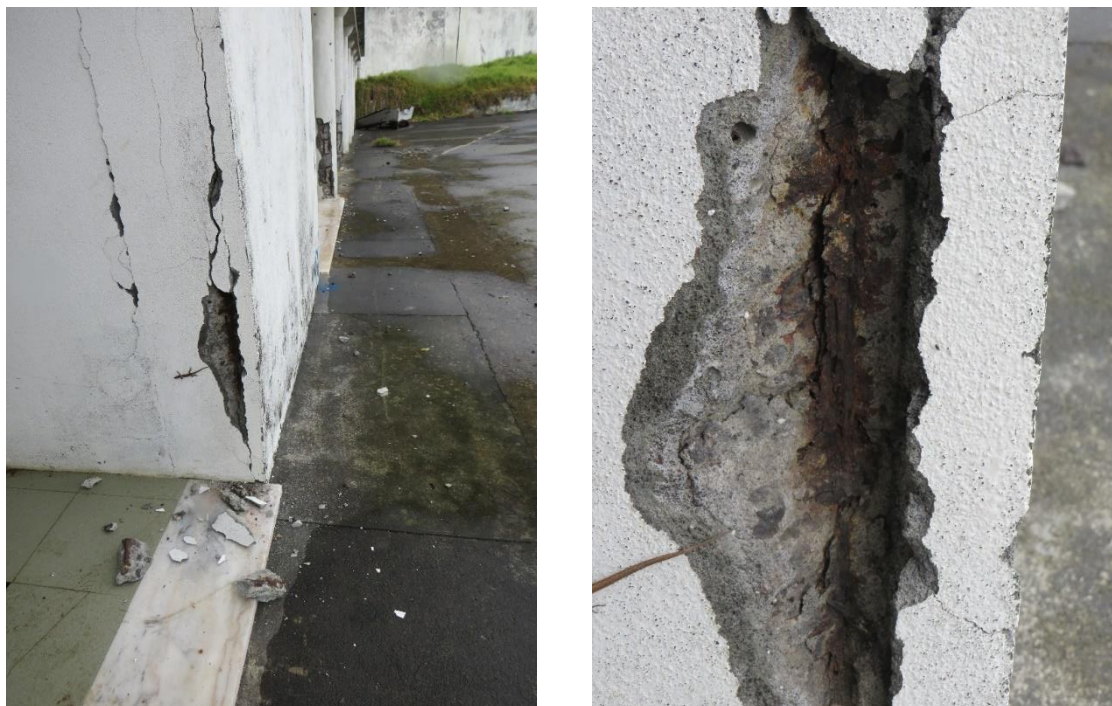
Figura 9 – Fissuração, destacamento de betão da camada de recobrimento e corrosão de armaduras em pilar exterior.
