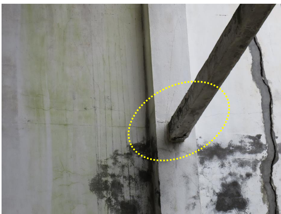
Figura 42 – Fissuração em viga de pequenas dimensões existente a meia altura do edifício.
