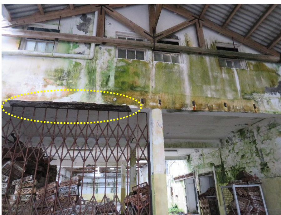
Figura 85 – Destacamento de betão da camada de recobrimento e corrosão de armaduras em viga. Sinais de elevada humidade.
