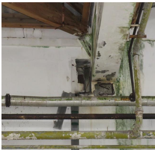
Figura 63 – Manchas de humidade e corrosão dos elementos metálicos (tubagem, perfis em I) e podridão da madeira da estrutura da cobertura.
