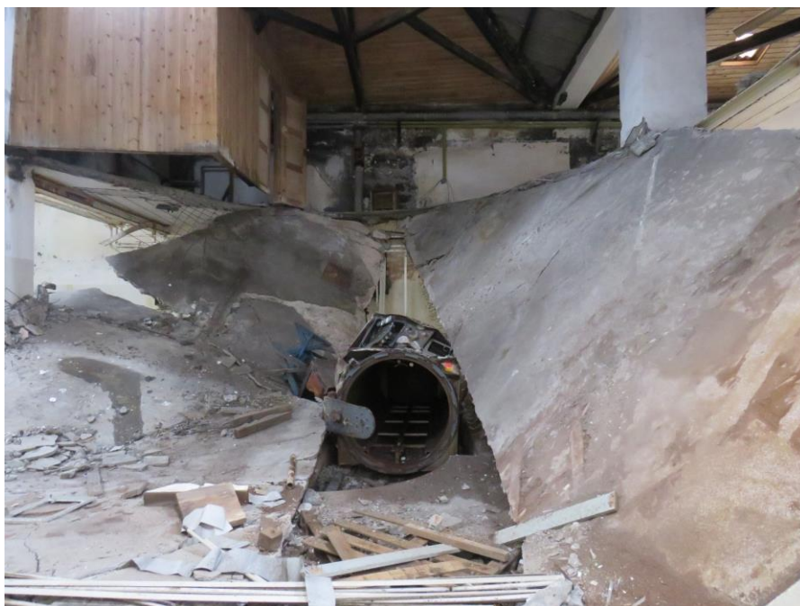
Figura 71 – Queda parcial da maciça de betão armado do Piso 1, no Compartimento 11.6.
