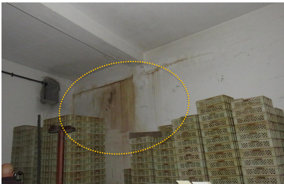
Figura 28 – Vestígios de humidade no paramento interior da fachada Poente.
