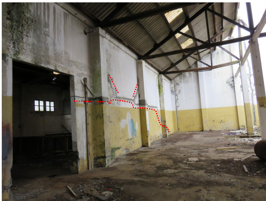
Figura 41 – Fissuras existente na parede Norte.
