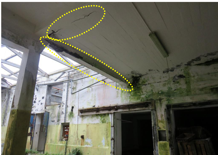
Figura 86 – Destacamento de betão da camada de recobrimento e corrosão de armaduras em viga sob o corpo 13.
