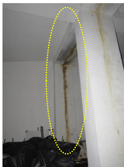
Figura 27 – Indícios de infiltrações de águas pluviais na zona da junta de dilatação, no espaço orientado a Norte do Corpo 3.
