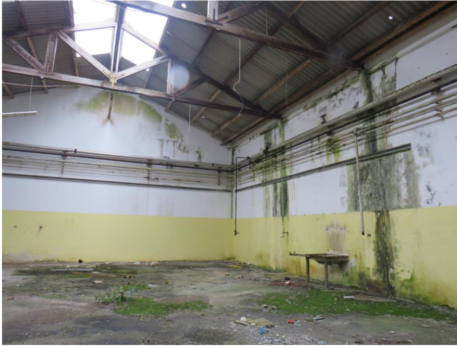
Figura 56 – Manchas de humidade em paredes e pavimento. Ausência de elementos do revestimento da cobertura.
