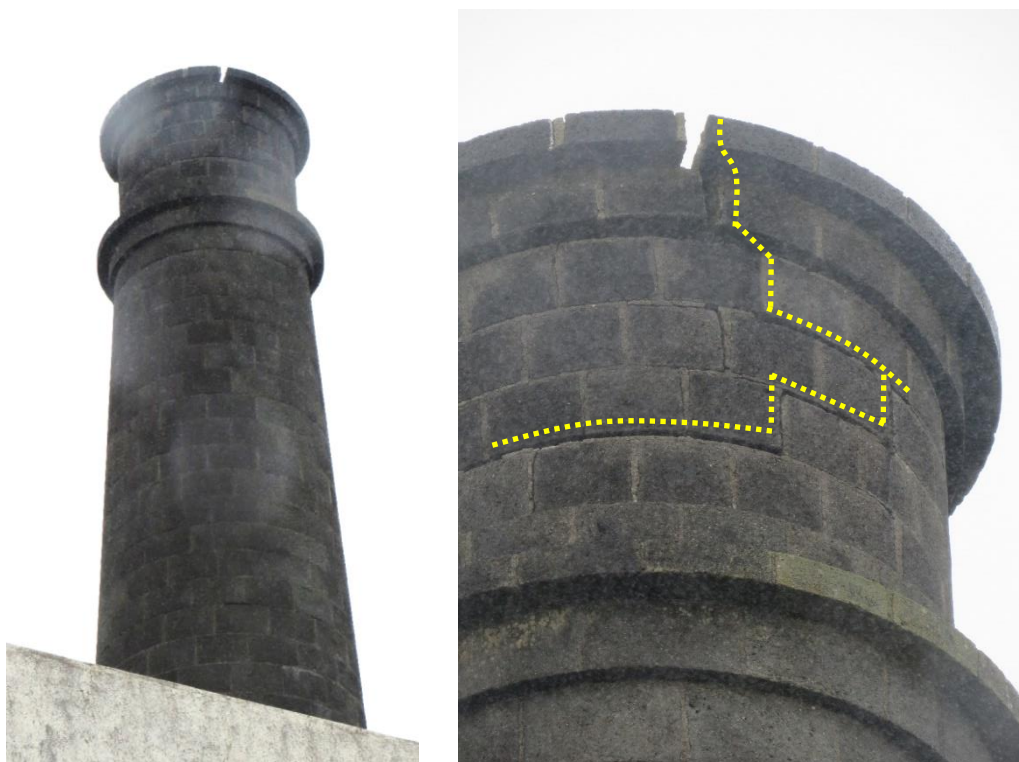
Figura 88 – Aspeto da chaminé vista de Sul. Pormenor da fenda observada.
