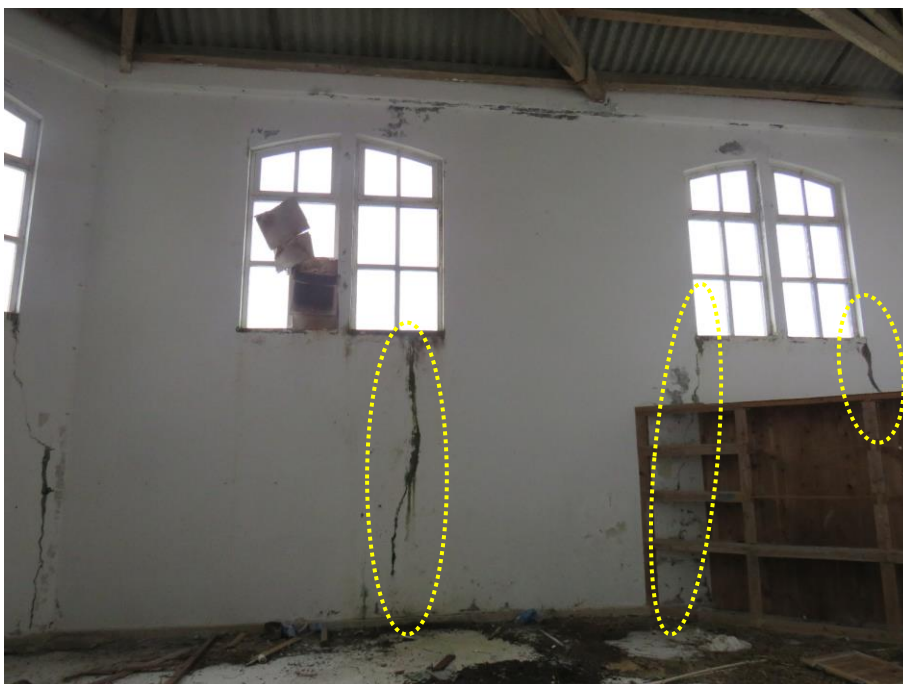
Figura 36 – Fissuras com manchas de humidade no paramento interior da fachada Poente.
