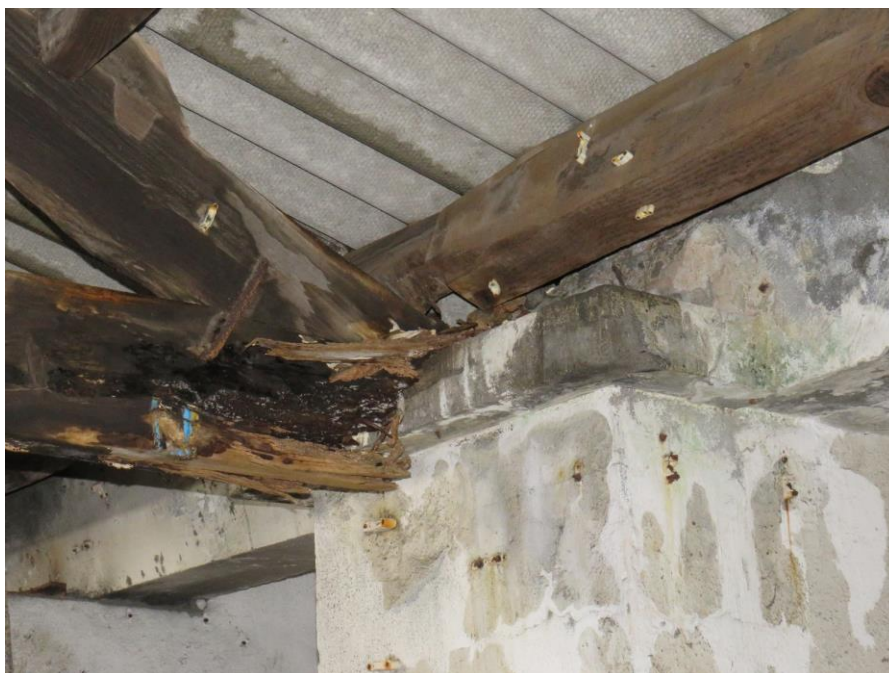
Figura 76 – Podridão dos apoios das asnas em madeira da estrutura da cobertura, no Piso 1, sobre o Compartimento 11.3.
