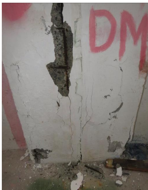
Figura 24 – Fissuração, destacamento de betão da camada de recobrimento e corrosão de armaduras na base dos pilares adjacentes a junta de dilatação, na fachada Sul.
