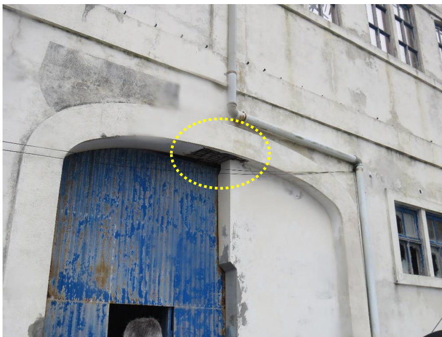
Figura 17 – Destacamento de betão da camada de recobrimento e corrosão de armaduras na face inferior do lintel, na fachada Sul do edifício.
