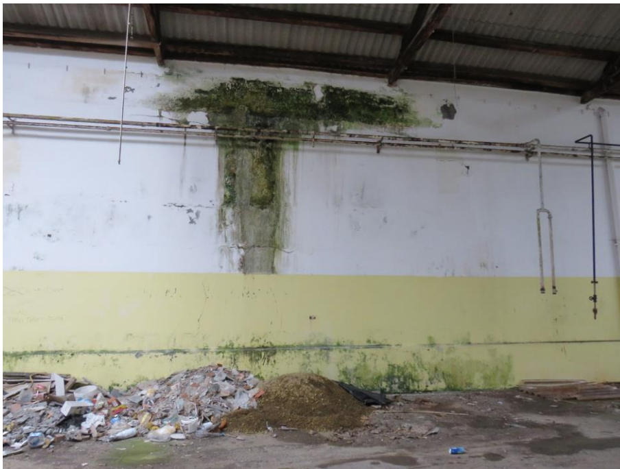
Figura 59 – Manchas de humidade na parede Norte.
