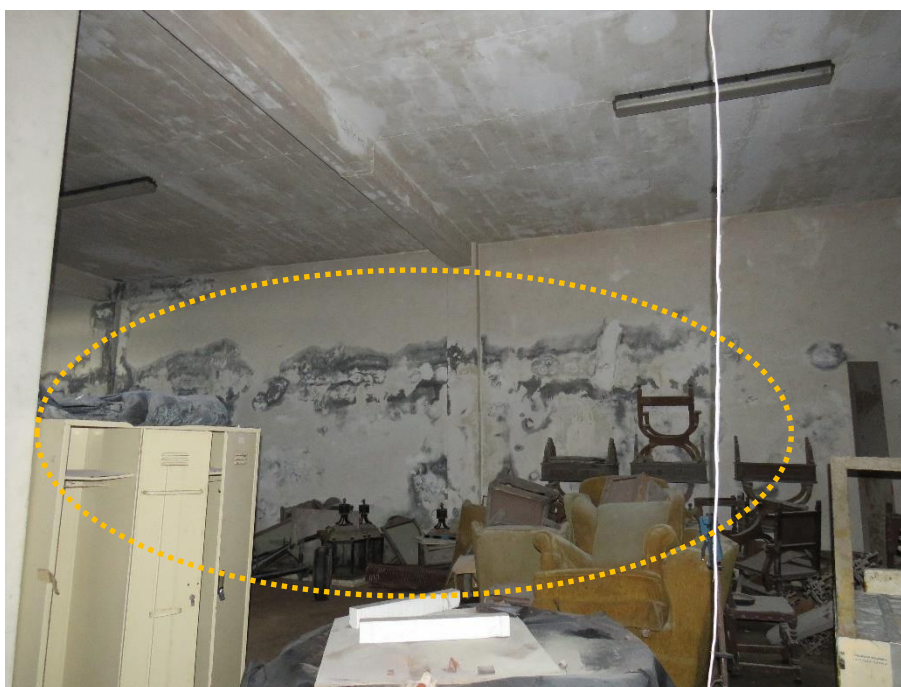
Figura 21 – Criptoflorescências no muro de suporte a Norte, do Piso 0.
