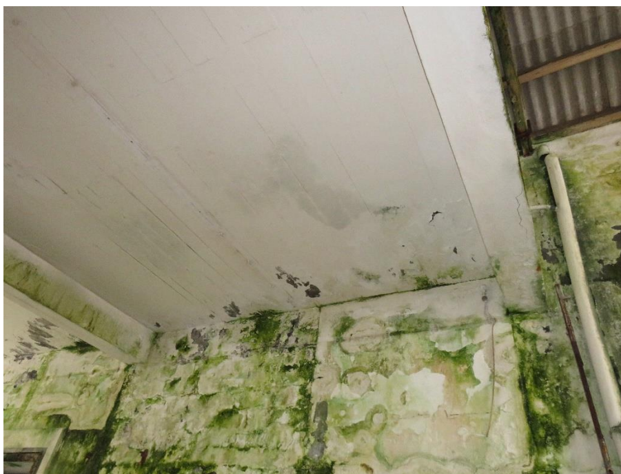
Figura 83 – Sinais de elevada humidade sob o corpo 13.
