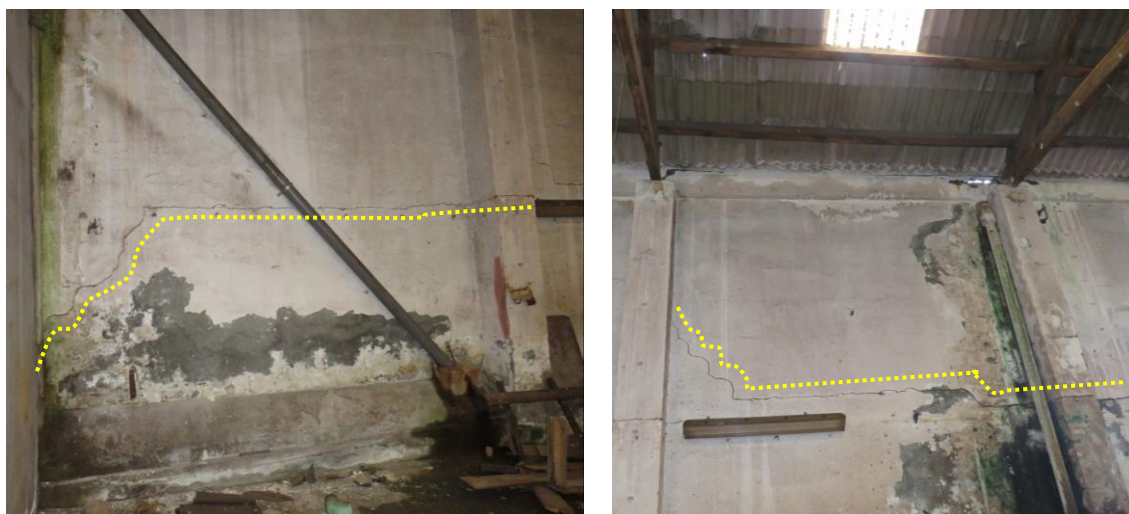
Figura 47 – Fissuras e manchas de humidade em parede Sul, com maior incidência na zona de tubo de queda.
