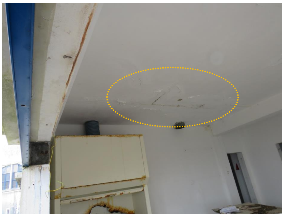
Figura 37 – Indícios de humidade na face inferior da laje de teto.
