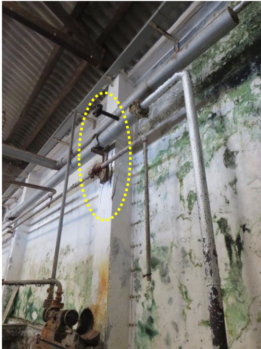
Figura 51 – Manchas de humidade e corrosão de elementos metálicos em parede Norte. Fissuração em pilar.
