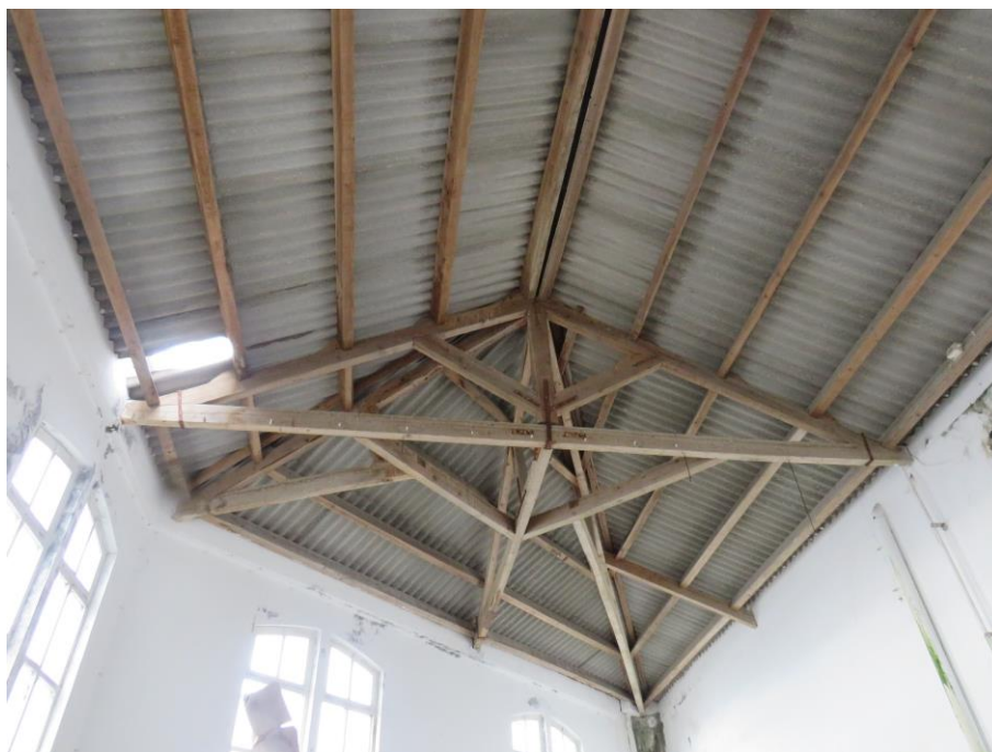
Figura 34 – Estado geral da estrutura de madeira da cobertura.
