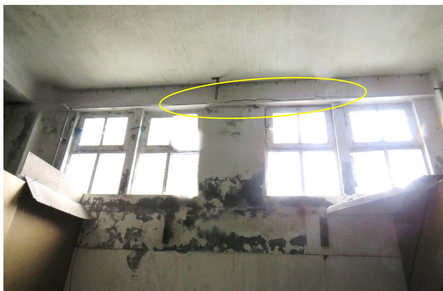
Figura 20 – Criptoflorescências em paramento interior da fachada Sul e fissuração em viga, no Piso 0.
