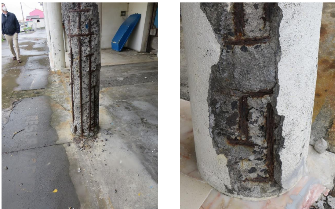
Figura 11 – Pormenor do estado avançado de corrosão de armaduras em diversos pilares do Piso 0 na fachada Sul.
