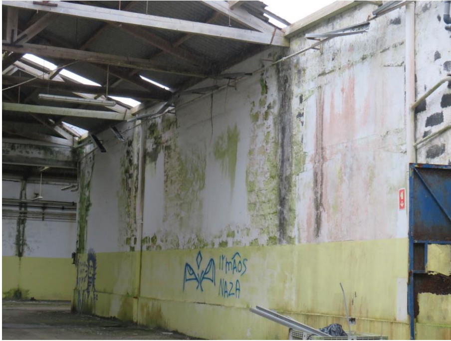
Figura 58 – Manchas de humidade e ausência de elementos do revestimento da cobertura.
