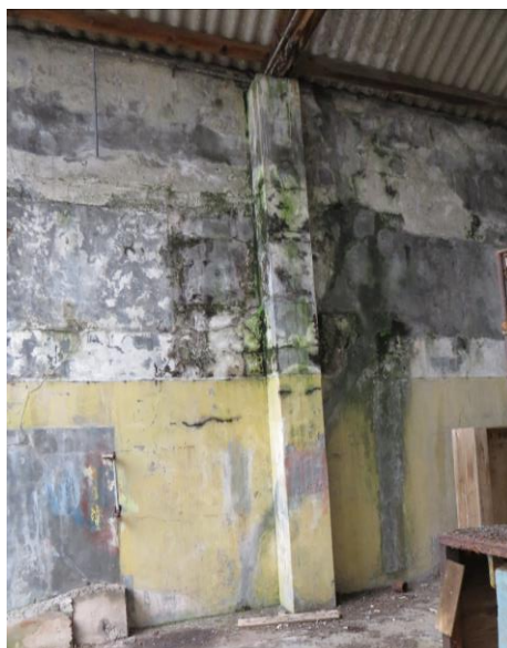
Figura 45 – Fissuração e manchas de humidade com consequente podridão do apoio da asna de madeira da estrutura da cobertura.
