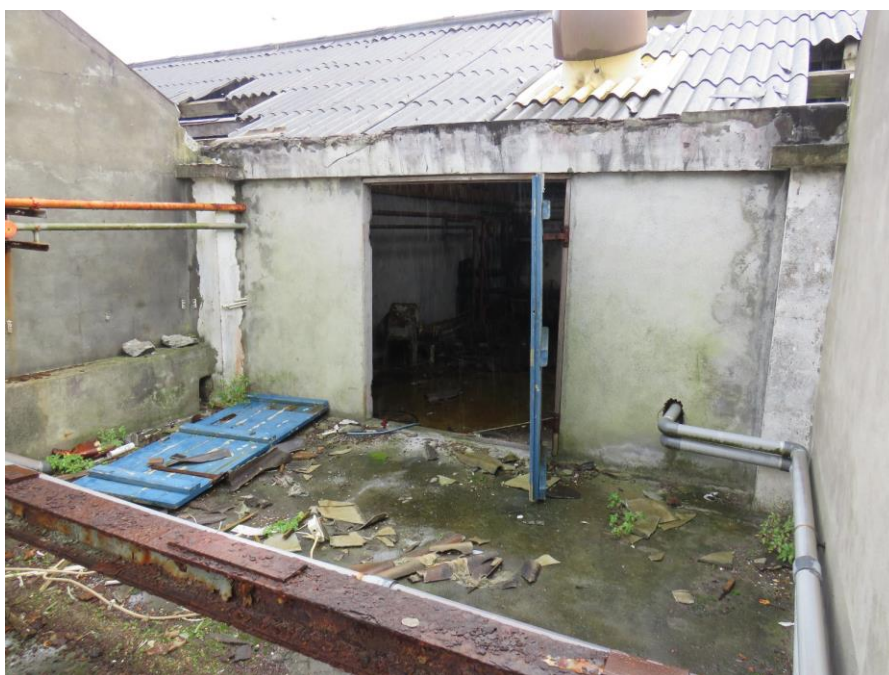
Figura 79 – Corrosão de perfis metálicos presentes no Piso 1, sobre o compartimento 11.2.
