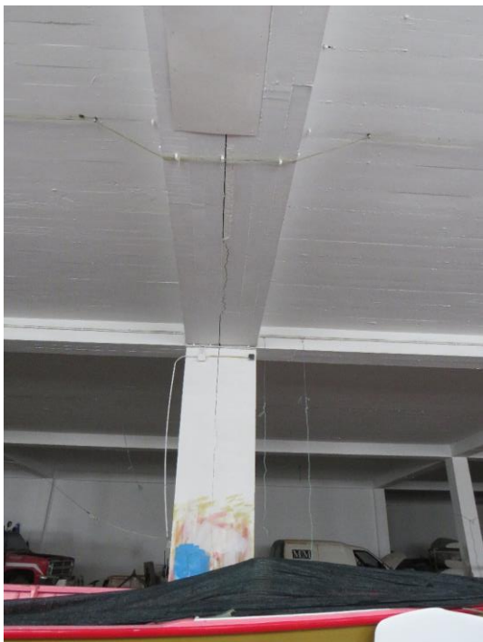
Figura 25 – Abertura da junta de dilatação, entre vigas.
