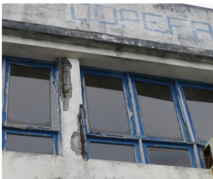
Figura 12 – Destacamento de betão da camada de recobrimento e corrosão de armaduras em pilar e degradação da caixilharia de madeira, na fachada Sul.
