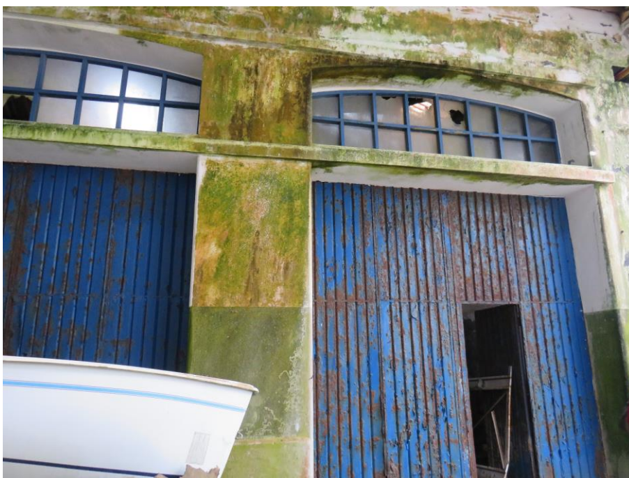
Figura 67 – Sinais de humidade e corrosão dos portões metálicos na entrada dos compartimentos 11.3.
