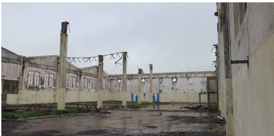
Figura 13 – Aspeto geral do interior do Piso 1 do Corpo 2: ausência da estrutura da cobertura.
