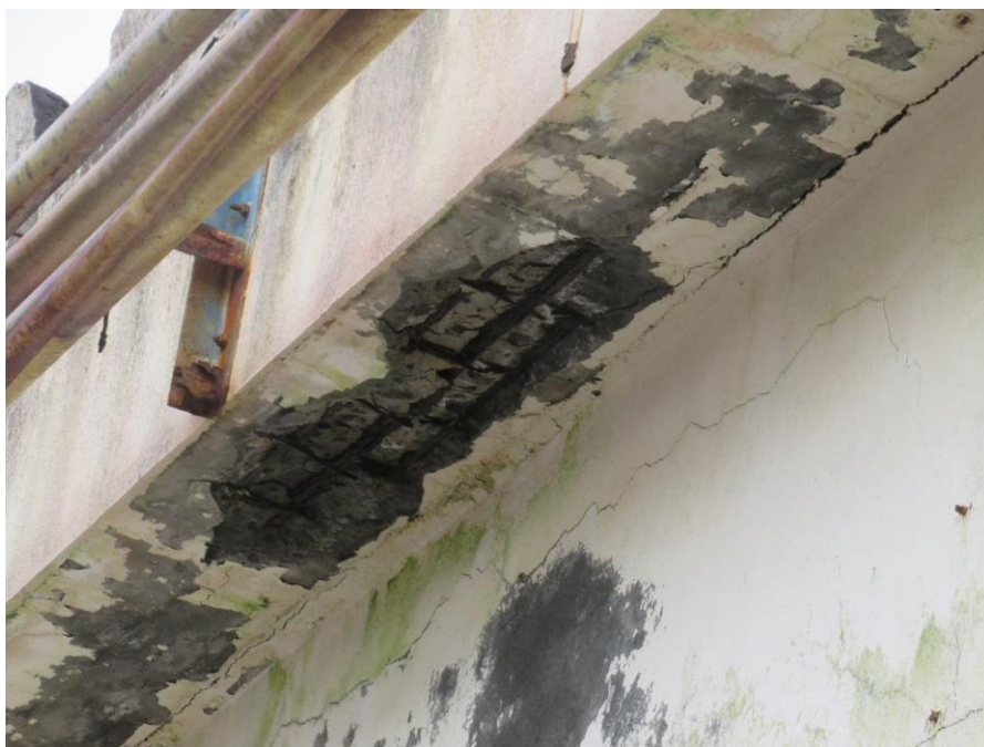
Figura 78 – Fissuração, destacamento de betão da camada de recobrimento e corrosão de armadura em viga na cobertura do Piso 1, sobre o compartimento 11.2.
