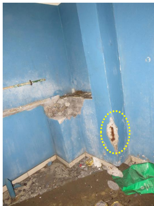
Figura 69 – Compartimento 11.5: à esquerda, fissura diagonal; à direita, destacamento de betão da camada de recobrimento e corrosão de armaduras.
