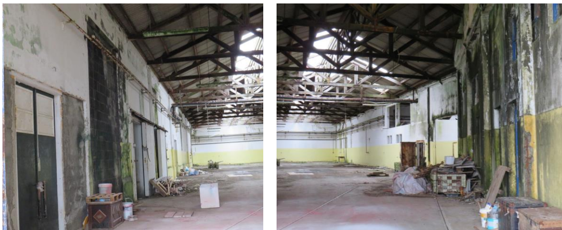
Figura 55 – Aspeto da zona de circulação vista da entrada Sul: manchas de humidade, destacamento de betão da camada de revestimento, corrosão de armaduras e outros elementos metálicos e ausência pontual de revestimento da cobertura.
