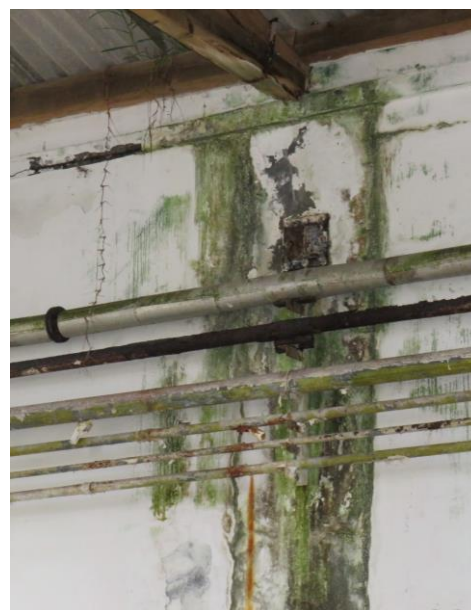
Figura 63 – Manchas de humidade e corrosão dos elementos metálicos (tubagem, perfis em I) e podridão da madeira da estrutura da cobertura.
