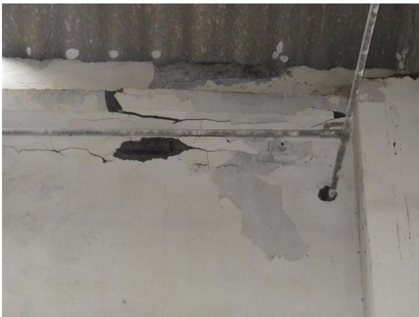
Figura 49 – Fissuração, destacamento de betão da camada de recobrimento e corrosão de armaduras em vigas.
