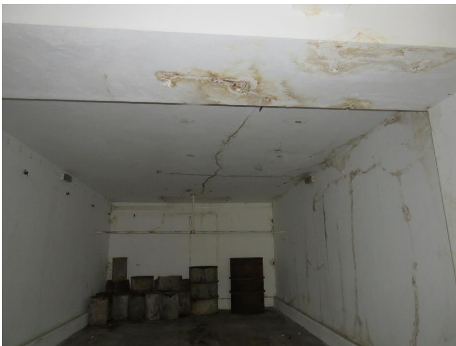
Figura 66 – Fissuração e manchas de humidade no compartimento 11.2
