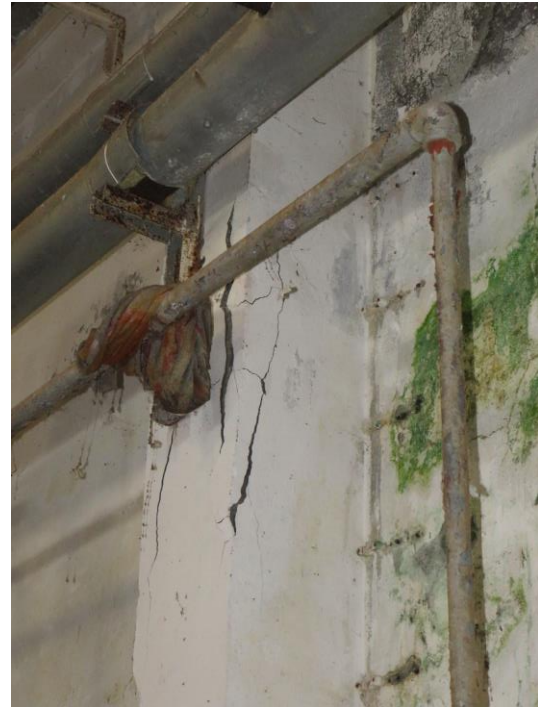
Figura 51 – Manchas de humidade e corrosão de elementos metálicos em parede Norte. Fissuração em pilar.
