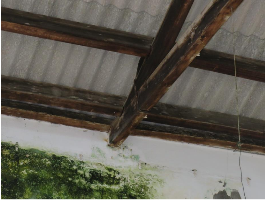
Figura 60 – Podridão da madeira da estrutura da cobertura, em particular na zona dos apoios.
