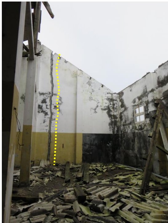
Figura 43 – Queda parcial da cobertura e fenda vertical na fachada Nascente.
