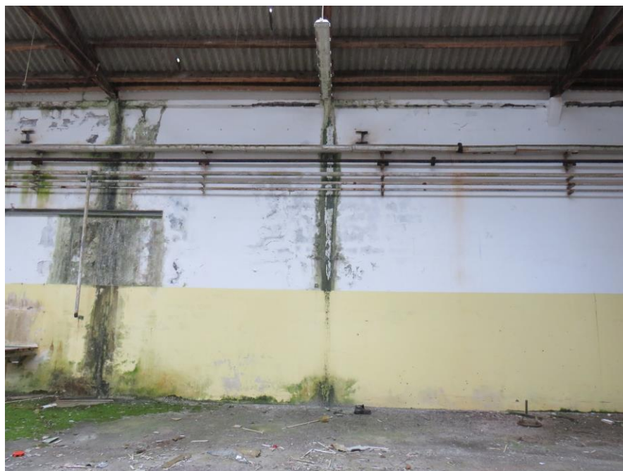
Figura 62 – Manchas de humidade e corrosão de elementos metálicos (tubagem, perfis em I, armadura da viga) e podridão da madeira da estrutura da cobertura.
