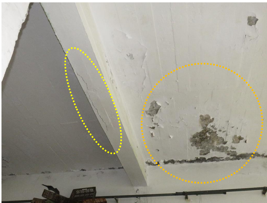
Figura 84 – Fissuração na face inferior de viga sob o corpo 13. Destacamento de pintura.
