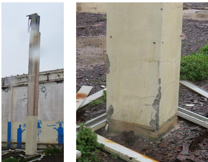
Figura 14 – Deformação vertical de pilar, sendo visível a fissuração dos esforços de flexão resultantes na base.
