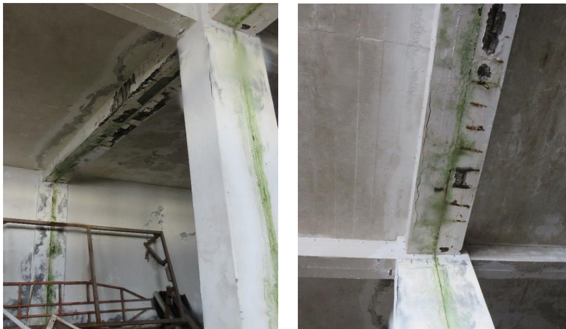
Figura 19 – Destacamento de betão da camada de recobrimento e corrosão de armaduras em vigas adjacentes a junta de dilatação, no Piso 0. Destacamento de pintura e manchas de humidade.
