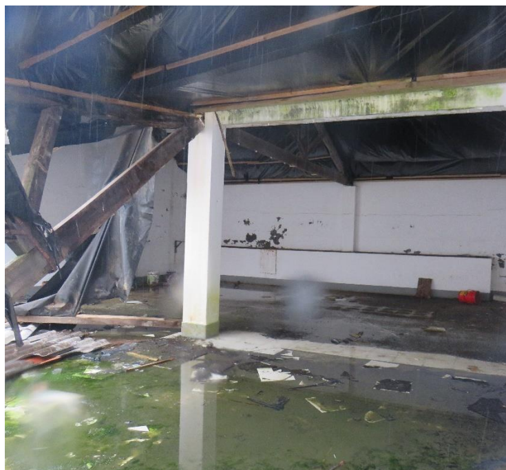
Figura 82 – Água acumulada na laje de pavimento. Manchas de elevada humidade.
