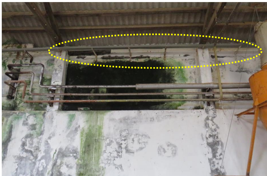
Figura 52 – Manchas de elevada humidade. Fissuração, destacamento de betão da camada de recobrimento e corrosão de armadura em vigas.
