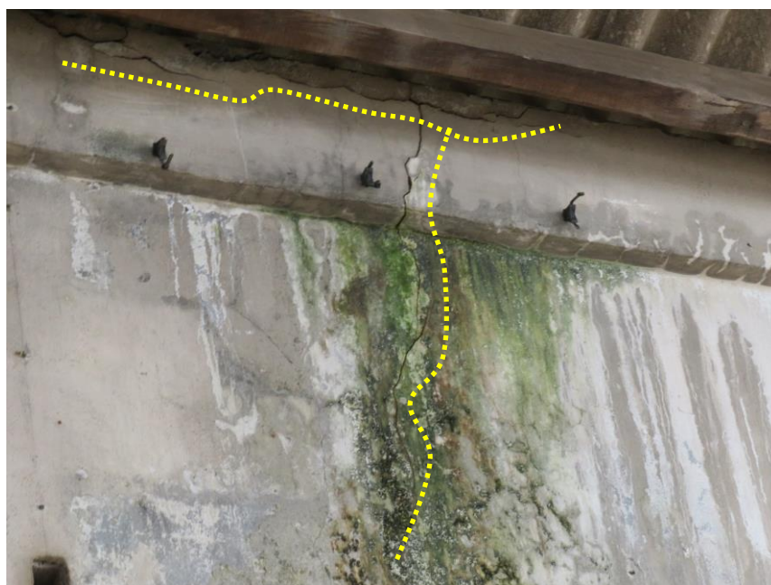
Figura 40 – Fissuração em parede e viga e manchas de humidade na parede Norte.
