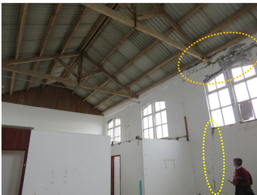
Figura 31 – Destacamento de pintura e fissura no paramento interior da fachada Sul, visível também pelo exterior (figura anterior ).
