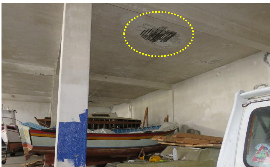
Figura 18 – Destacamento de betão da camada de recobrimento e corrosão de armadura na face inferior da laje de teto do Piso 0.
