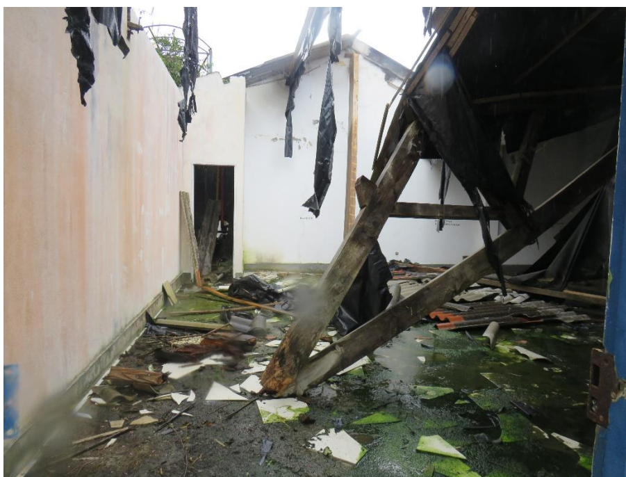
Figura 81 – Queda parcial da estrutura da cobertura.
