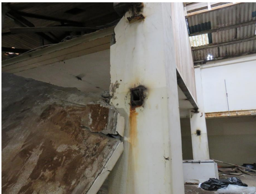
Figura 72 – Queda parcial da laje de betão armado do Piso 1 e corte de perfis metálicos, no Compartimento 11.6.
