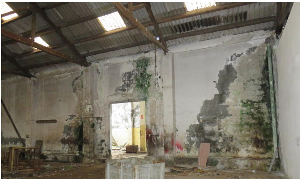
Figura 46 – Indícios de humidade, destacamento de pintura e fissuração em parede Sul.
