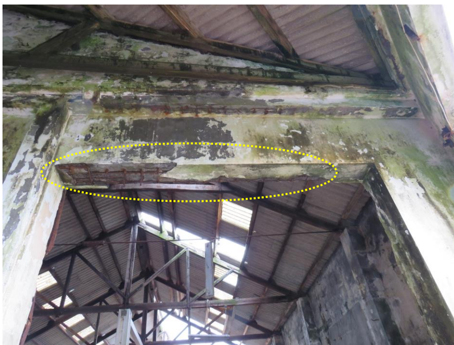
Figura 39 – Colonização biológica, destacamento de pintura, destacamento de betão da camada de recobrimento e corrosão de armaduras de vigas na entrada Poente.
