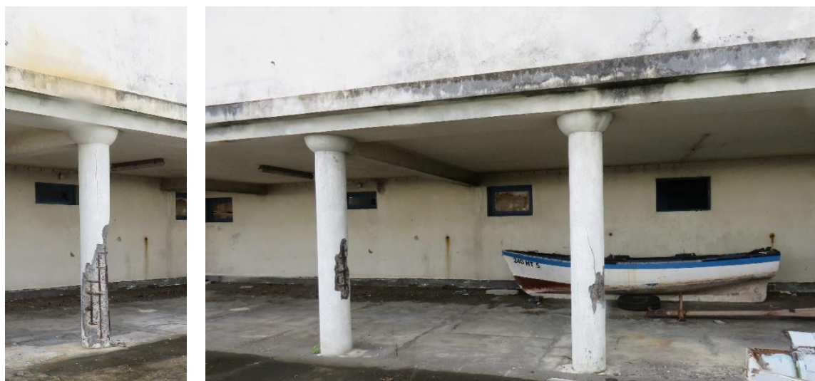
Figura 10 – Destacamento de betão da camada de recobrimento e corrosão de armaduras em diversos pilares do Piso 0 na fachada Sul.
