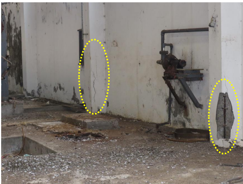
Figura 50 – Fissuração, destacamento de betão da camada de recobrimento e corrosão de armaduras na base dos pilares.
