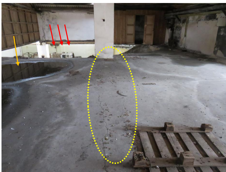
Figura 75 – Fissuração e presença de água na face superior da laje do Piso 1, no Compartimento 11.6. Queda parcial da laje.
