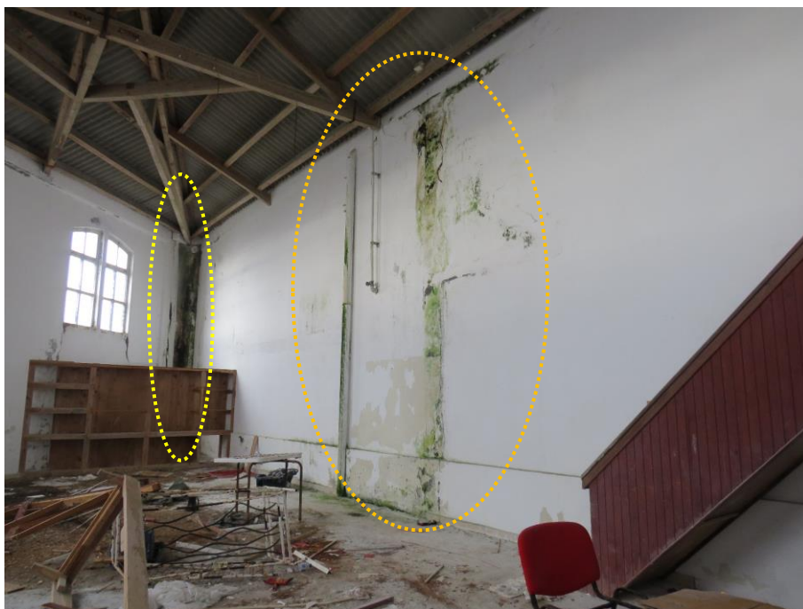
Figura 33 – Manchas de humidade, fissuração e destacamento de pintura em paramentos interior das paredes Poente e Norte.
