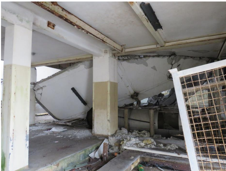
Figura 70 – Corrosão de elementos metálicos e queda parcial da laje de pavimento do Piso 1, no compartimento 11.6.
