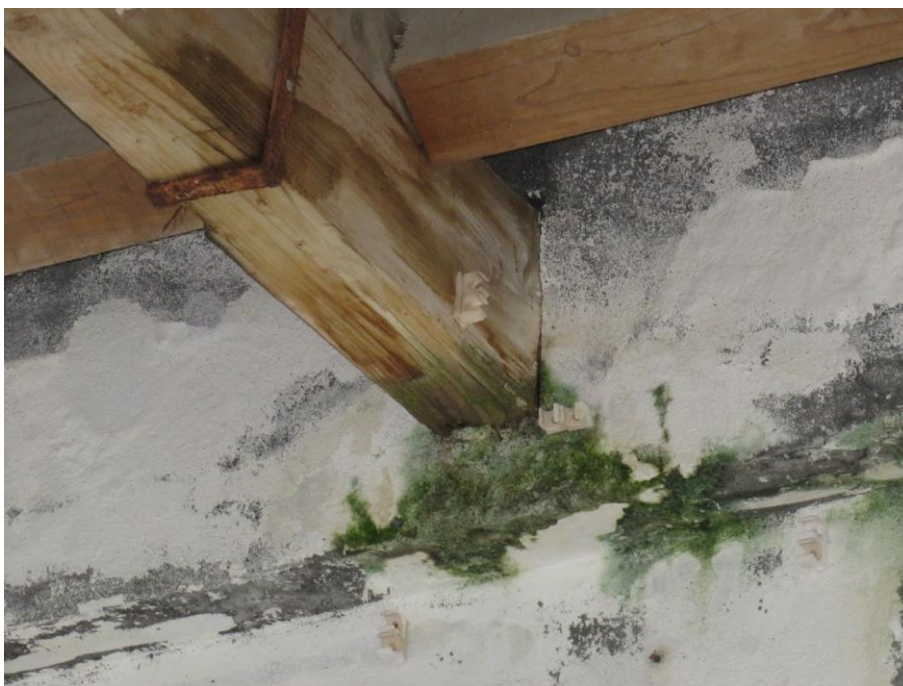
Figura 35 – Pormenor de um apoio da asna de madeira da estrutura da cobertura na parede: presença de humidade.
