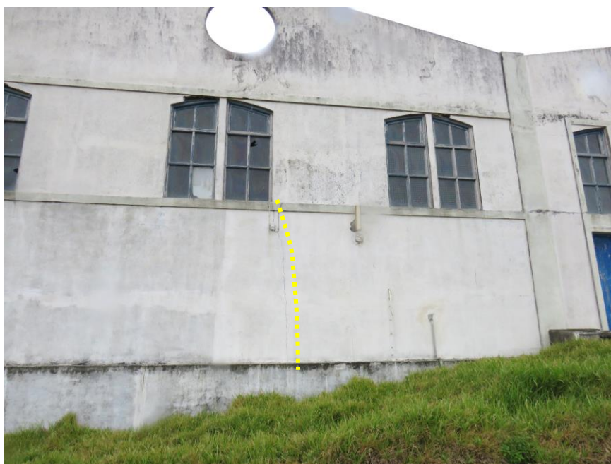
Figura 30 – Fissura na fachada Sul, visível também pelo interior (figura seguinte).
