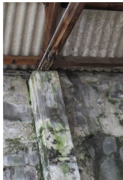
Figura 45 – Fissuração e manchas de humidade com consequente podridão do apoio da asna de madeira da estrutura da cobertura.
