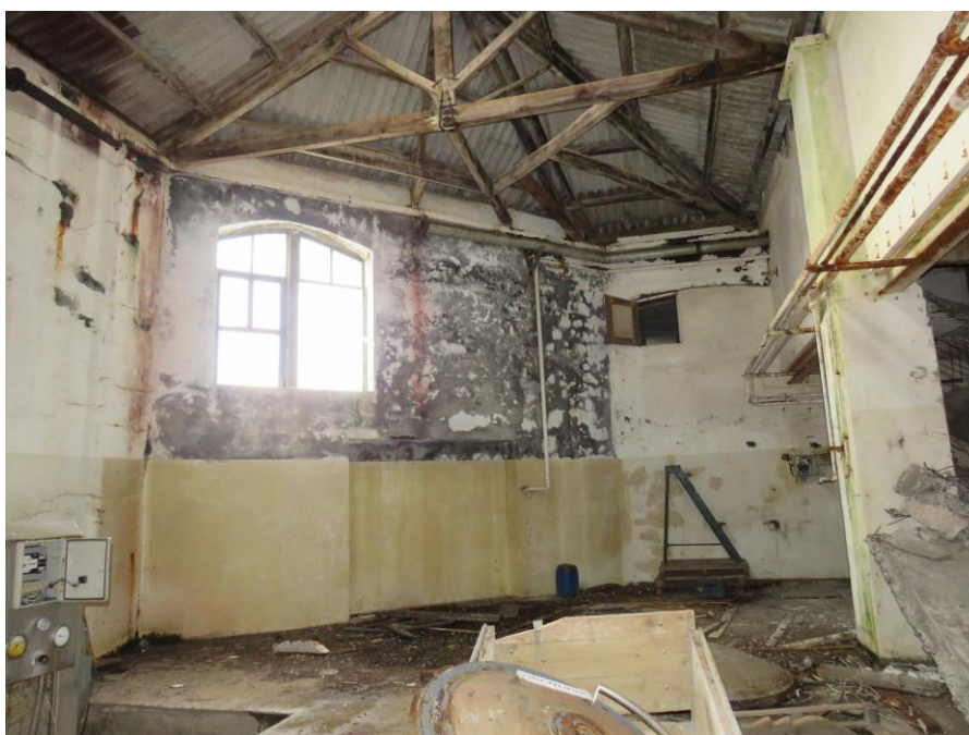
Figura 73 – Sinais de elevada humidade no Compartimento 11.6: destacamento de pintura, corrosão de elementos metálicos e podridão de elementos de madeira da estrutura da cobertura.
